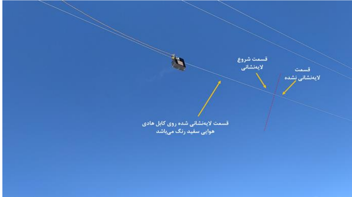
تصاویر پوشش‌دهی کابل هادی هوایی در مقیاس پایلوت
