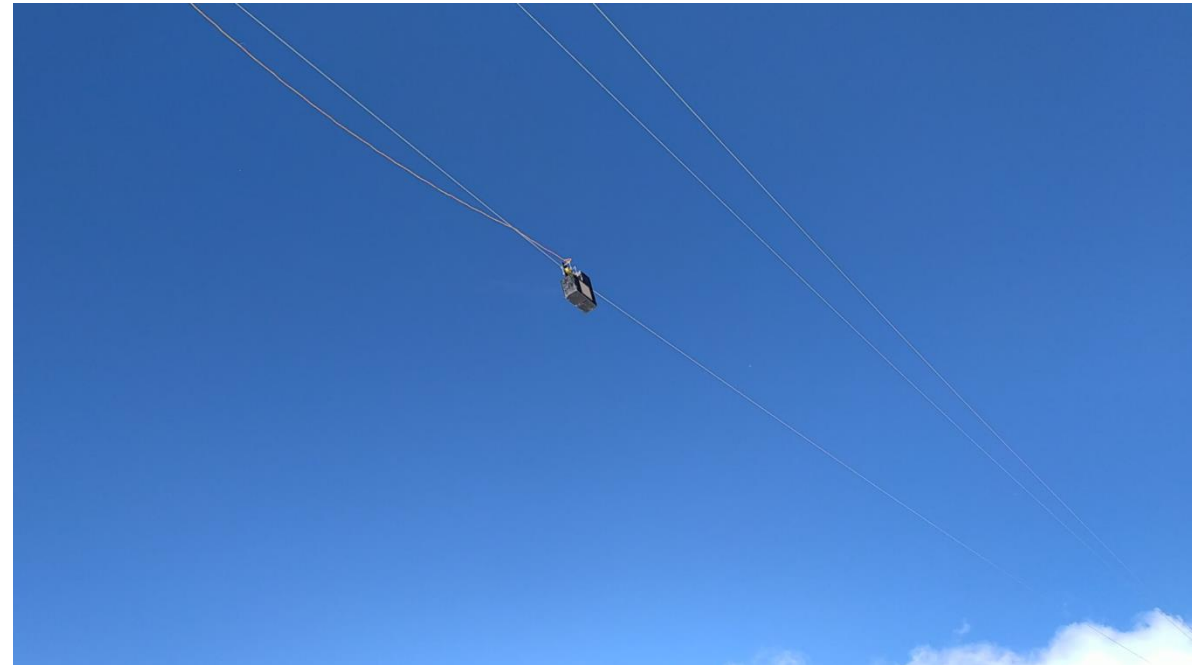
تصاویر پوشش‌دهی کابل هادی هوایی در مقیاس پایلوت
